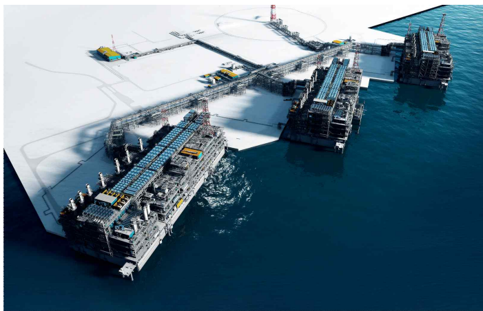
‘북극 LNG-2’ 프로젝트의 3개 생산 라인 (출처: ‘북극 LNG-2’)
