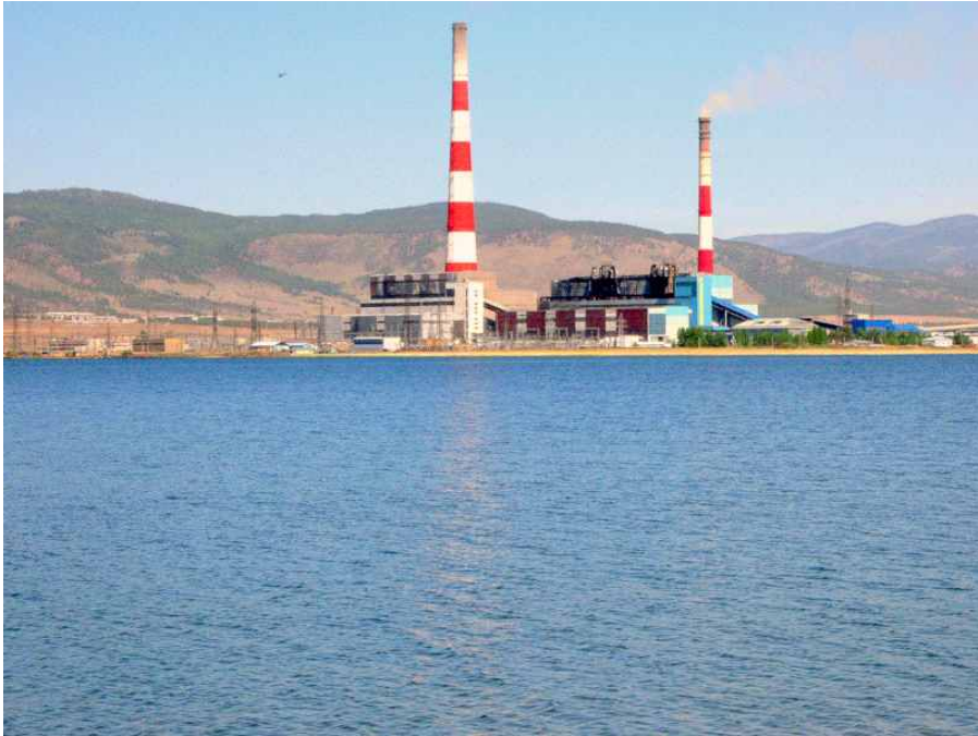
<그림29> 구시노오조르스카야 화력발전소
