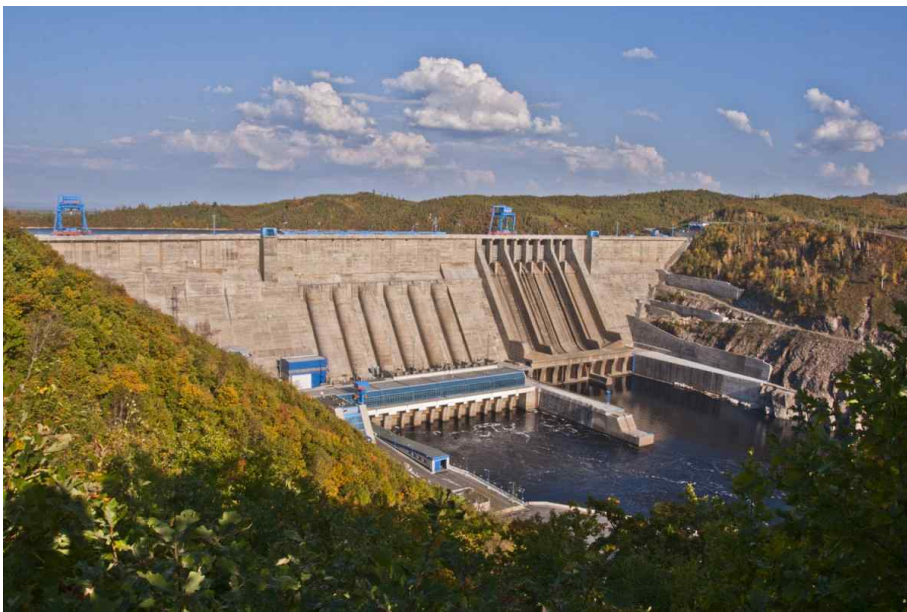
<그림 8> 부레이스카야 수력발전소(Бурейская ГЭС)
