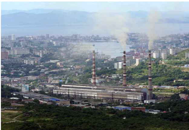
<그림 27> 블라디보스토크 제2화력발전소
