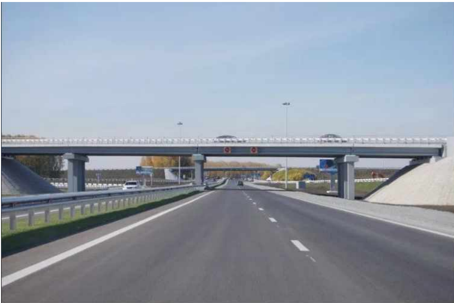
<그림 18> 케메로보-노보쿠즈네츠크 연방도로
