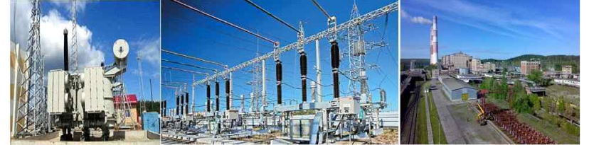
[그림 8. 코스트로마주 열 병합 발전소 현장]
